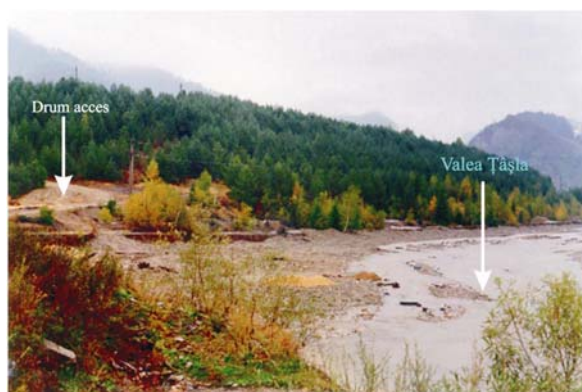
Figura 5 Taluzul lateral al iazului D3
