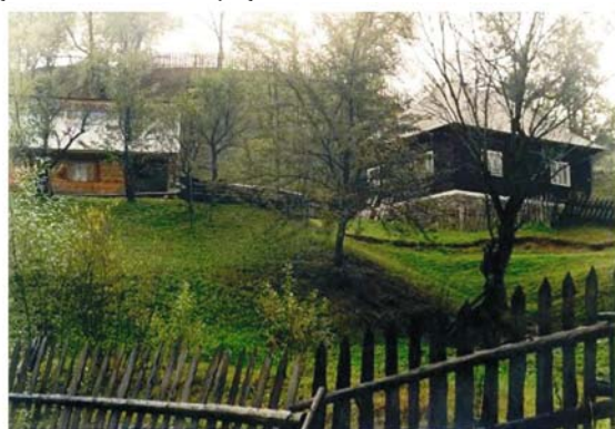
Figura 8 Gospodării afectate de alunecări
