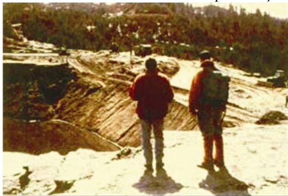
Figura 14 Lucrări de remediere a avariei barajului frontal (aprilie 2000)
